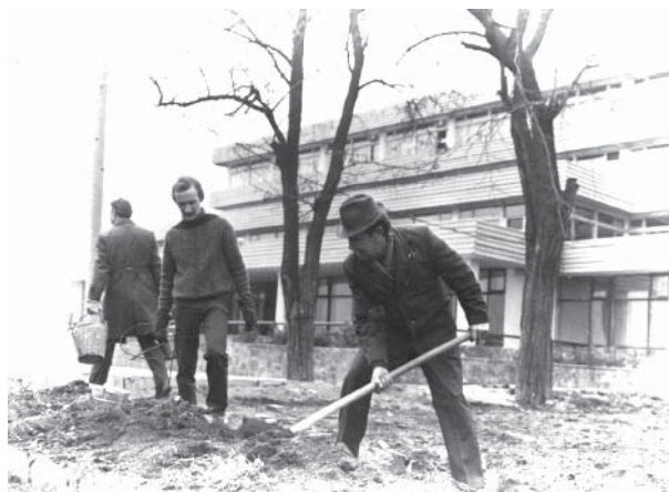
Строительство НИИ, начало 1980-х г.
