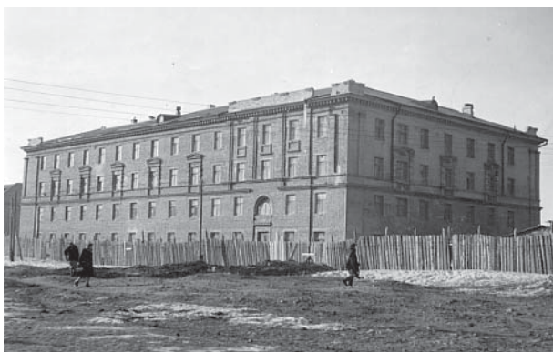
Строительство здания общежития №1
