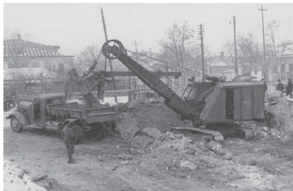
Строительство «профессорского» дома, 1953 г.
