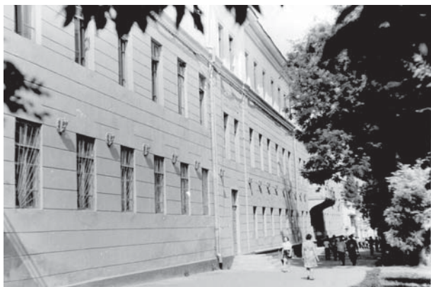
Здание ОКБ «Миус»
