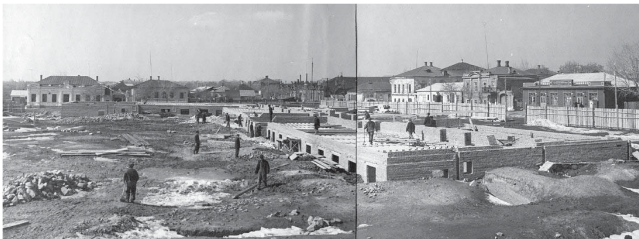
Строительство корпуса «Г», 1953 г.
