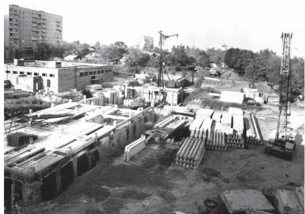
Строительная площадка экспериментально-опытного завода «Кремний», 1988 г.
