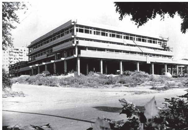
Стройка корпуса НИИ МВС, 1982 г.
