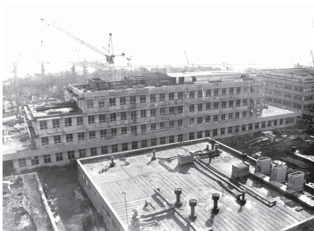
Стройка корпуса ОПБ НИИ МВС
