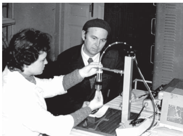
Испытания созданного ультразвукового терапевтического прибора для глазной поликлиники (рук. Ю.А. Сухомлинов)
