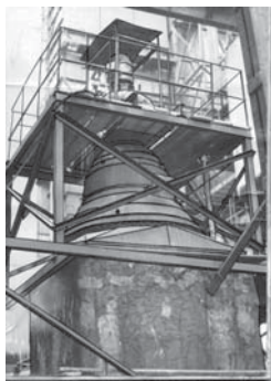
Коагуляционная установка на Новочеркасской ГРЭС по акустическому осаждению дымов, 1978 – 1988 гг.
